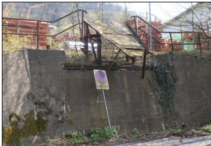
Der Zustand im Frühjahr 2012. Die Ladebucht dient als Wendepplatz für ein Fitnesscenter. Der einstigen Gleisflächen gehören zu einem Baustoffhandel. Foto Vampisol
