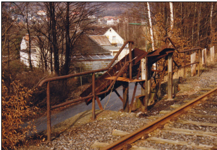
Die alte Münderer Schüttgutrutsche, Vor der Bahn im Jahre 1992. Inzwischen sind die Gleise längst abgebaut. Foto Martin Reuter
